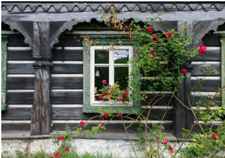
Profiliert: Säulen, Kopfbänder, Spannriegel, Zahnleiste
