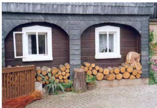
„Versetzen“ des Joches, Obercunnersdorf
