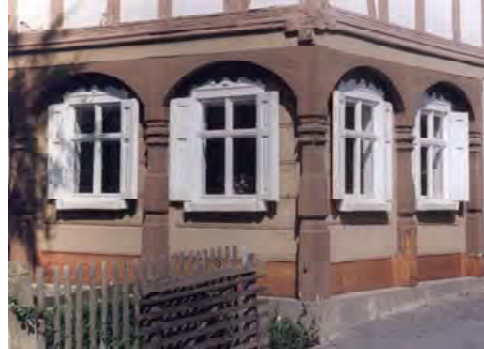
Profilierung von Umgebinesäulen (ein-, zwei-, dreiseitig)
