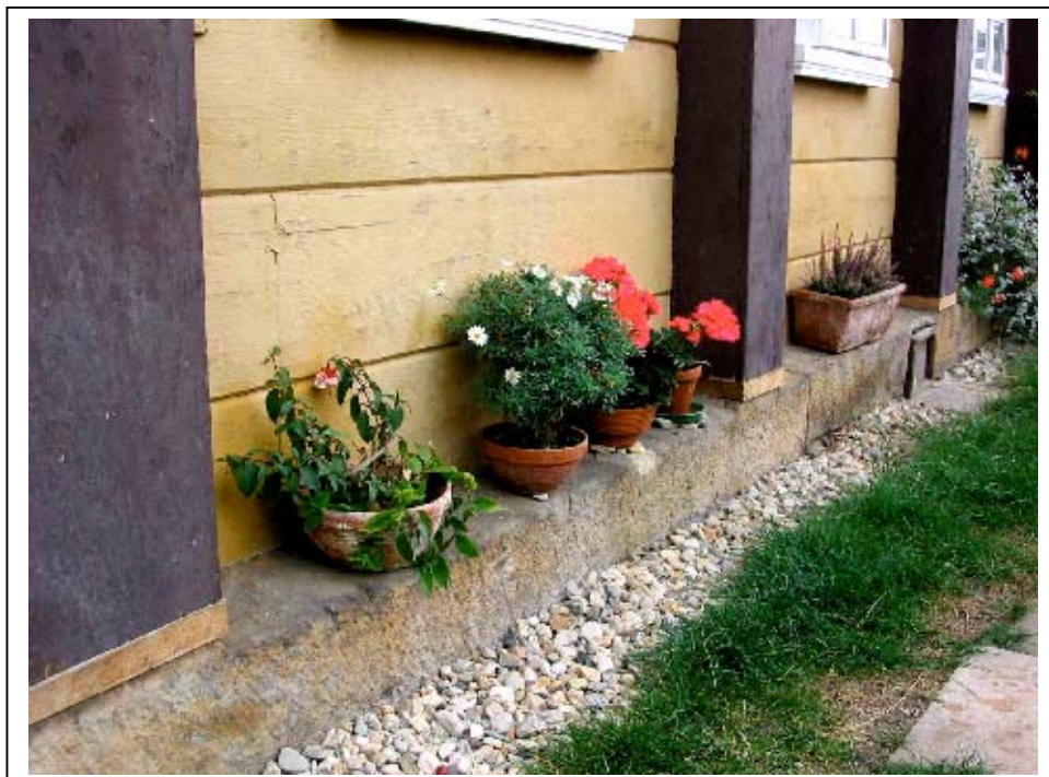
Bild 13: Ausführungsbeispiel eines Sockels mit Traufstreifen
