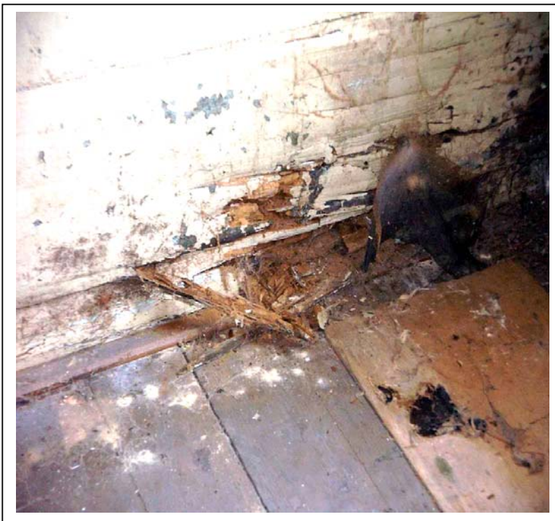
Bild 9: Braunfäule 9 an den Blockbohlen
