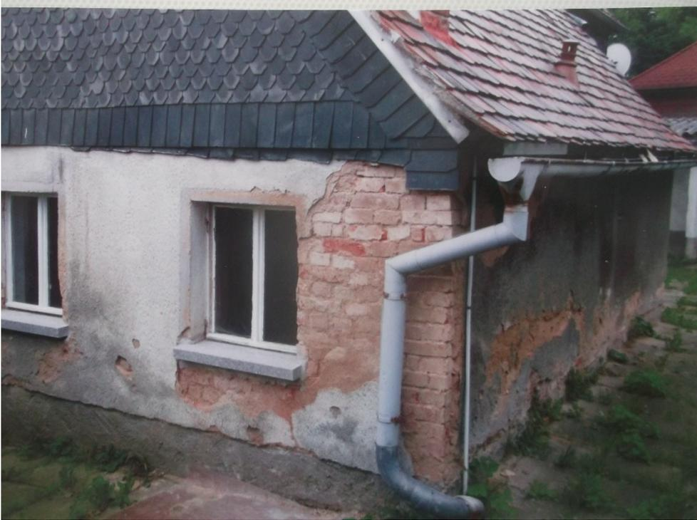
Die Putzschäden und die schadhafte Eindeckung des rückwärtigen Dachs waren nicht zu übersehen.
